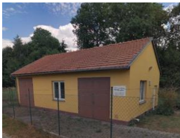
Obr. 29 Budova čističky a technologie, p. č. st. 499
