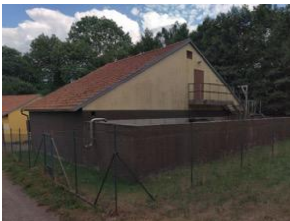
Obr. 28 Budova čističky a technologie, p. č. st. 498
